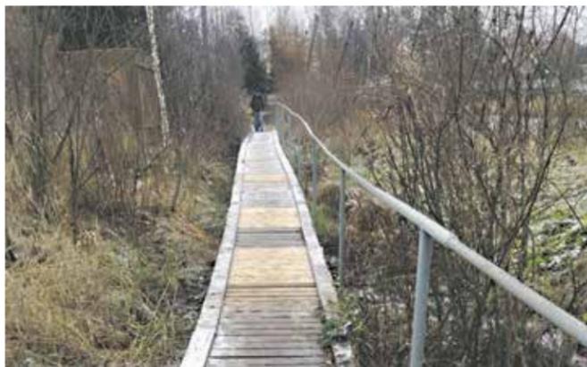
**На Кривом озере Токсовской службой заказчика были выполнены работы по частичному ремонту мостика. Гнилой и прохудивший настил был снят и частично заменен новыми досками. Теперь ходить по мостику стало безопасно и удобно!**
